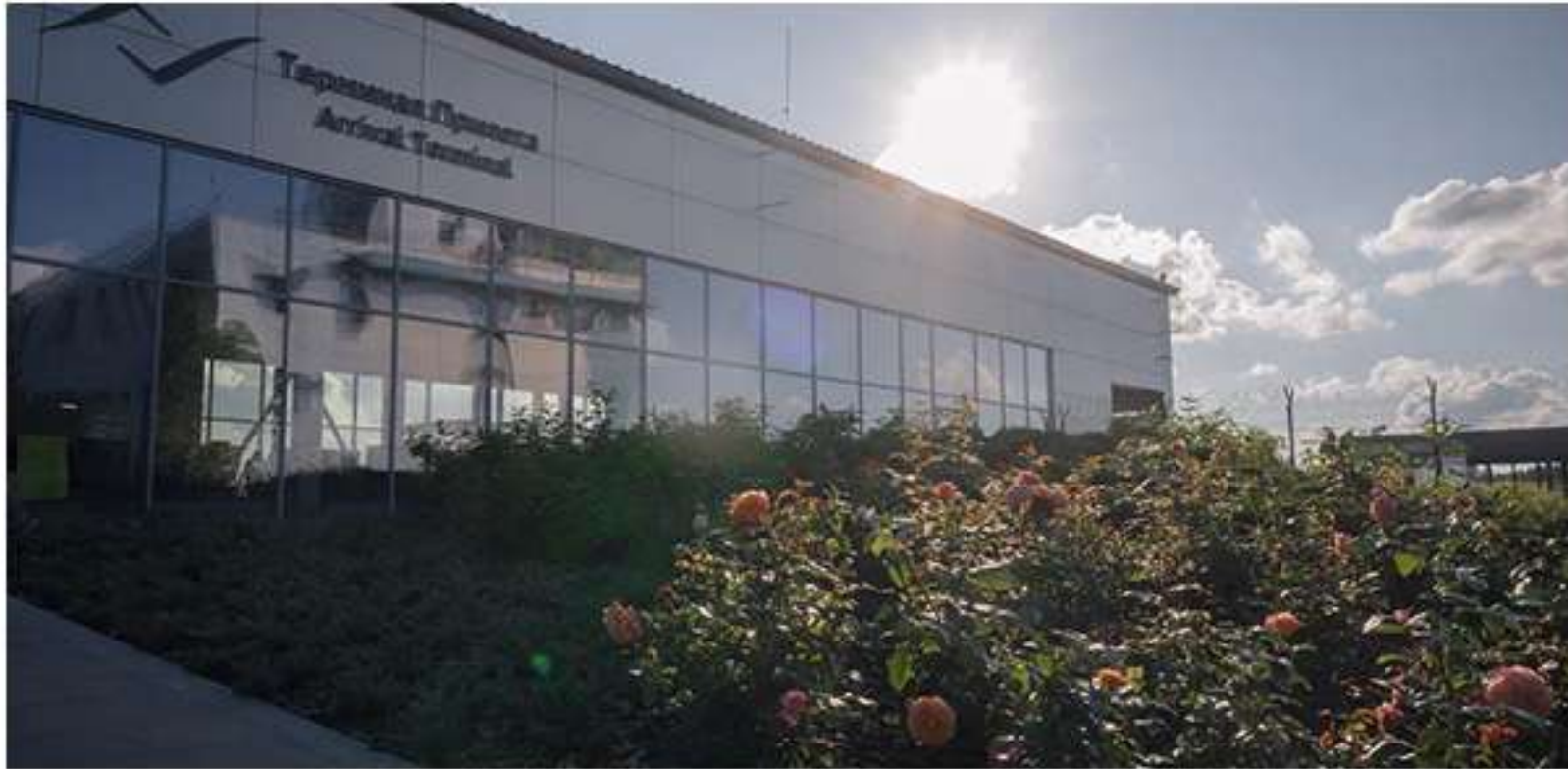
Терминал аэропорта Горно-Алтайск
